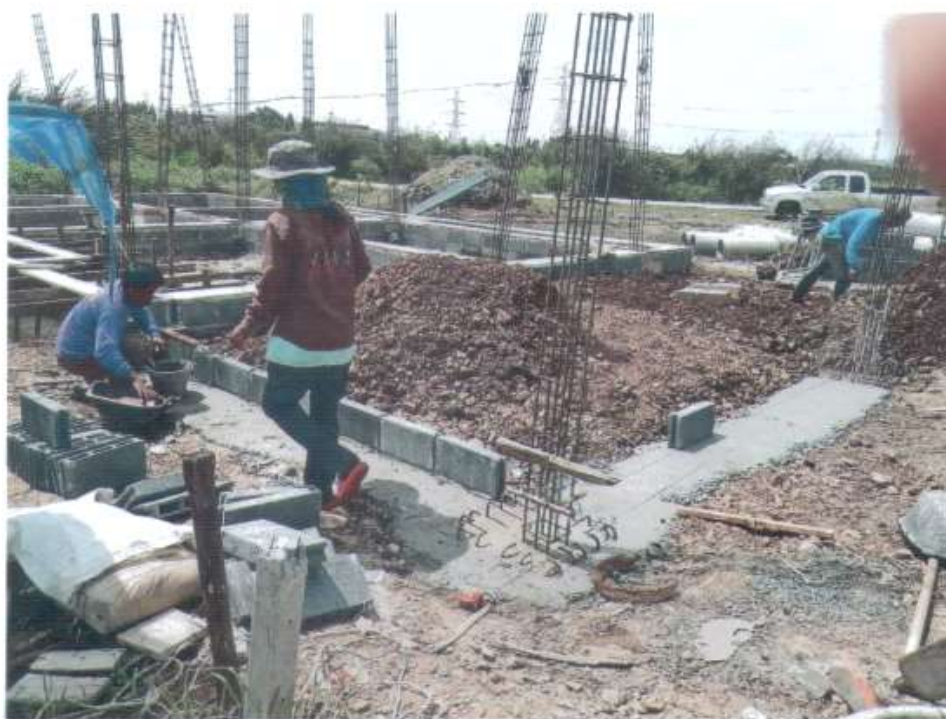
วันที่ 5 กันยายน 2561 ได้ดำเนินการก่อสร้างตามแบบบ้าน
